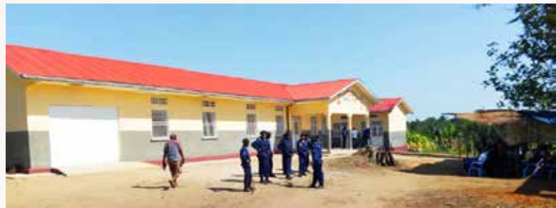
Le bâtiment de la CPLT Tshuapa à Boende, peu avant la cérémonie de sa remise officielle
