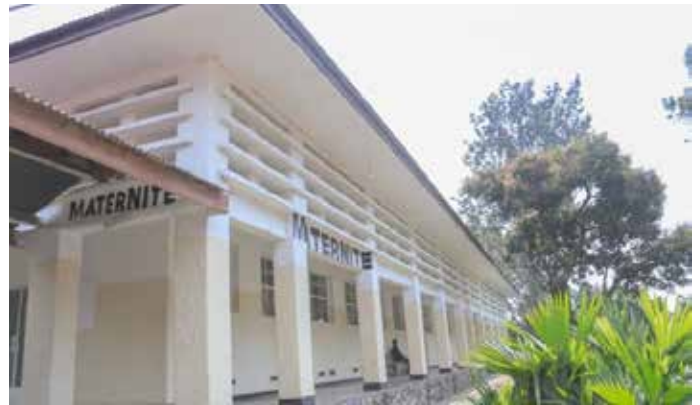
Vue partielle de la Maternité réhabilitée du HGR de Kirotshe
