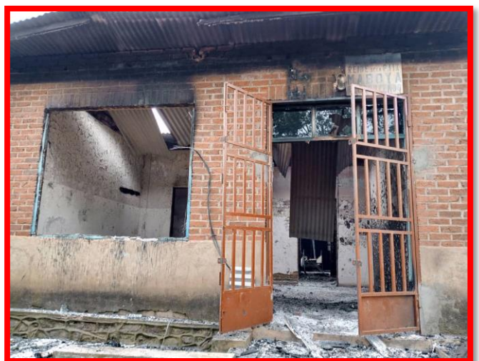
Bâtiment du Centre de Santé de Référence de MABOYA, pillé et incendié, avec des agents tués par les rebelles ADF la nuit du 19 au 20 octobre 2022. ©CARITAS BUTEMBO-BENI.
