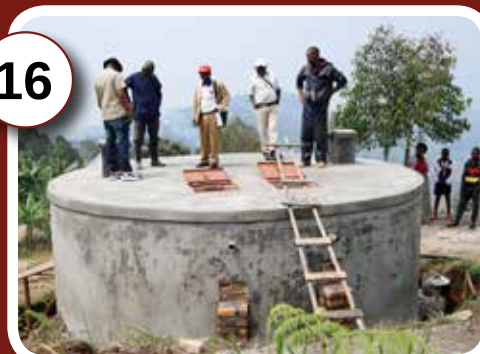
Construction des réservoirs d'eau par la Caritas Bukavu
