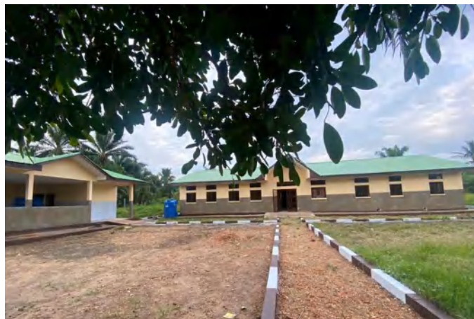
Travaux de finition, Centre de Santé Bakwa Mulumba/Lupatapata
